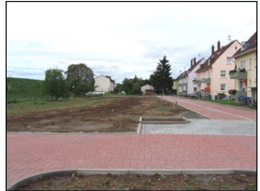
Plankstadt: Erschließungsstraße „Im Hebelgarten“
