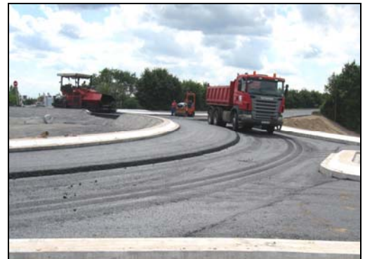
Der neue Kreisverkehrsplatz mit Zufahrt zum künftigen Gewerbegebiet ist bald fertiggestellt
