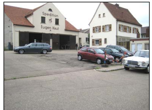
Am Ortseingang von Bad Dürkheim wird das bereits seit langem leer stehende Gebäude der Spedition Eugen Kaul im Zuge des Neubaus abgerissen
